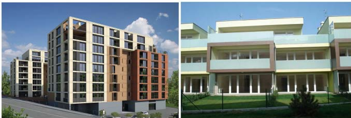
Slika 4 Stambeno poslovni objekti u Zagrebu
